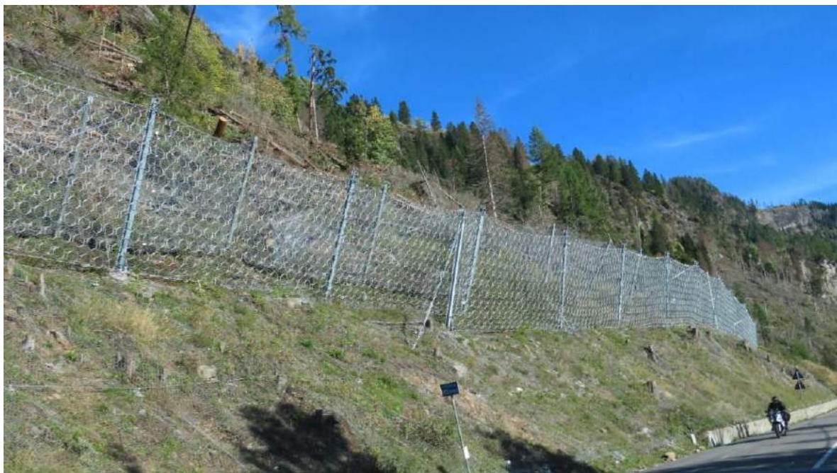
Figura 13 I paramassi incontrati sopra Caprile
