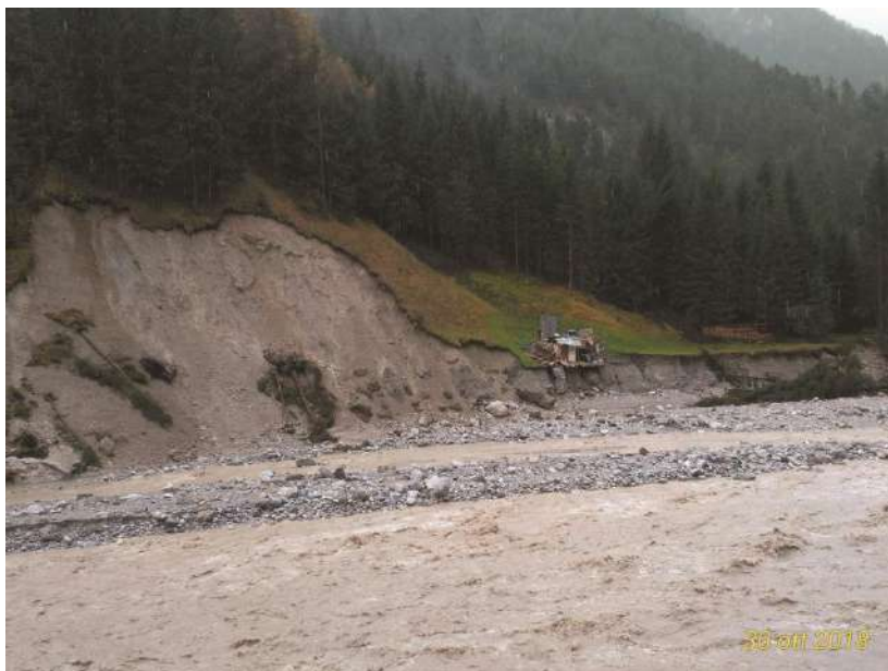
Immagine del 30 ottobre 2018. Sono visibili gli effetti della tempesta Vaia sulla sponda in destra idrografica del fiume Piave.
